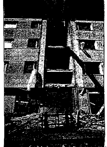
Porrashuoneiden ulkoseinät puretaan hissien asennuksen takia.
